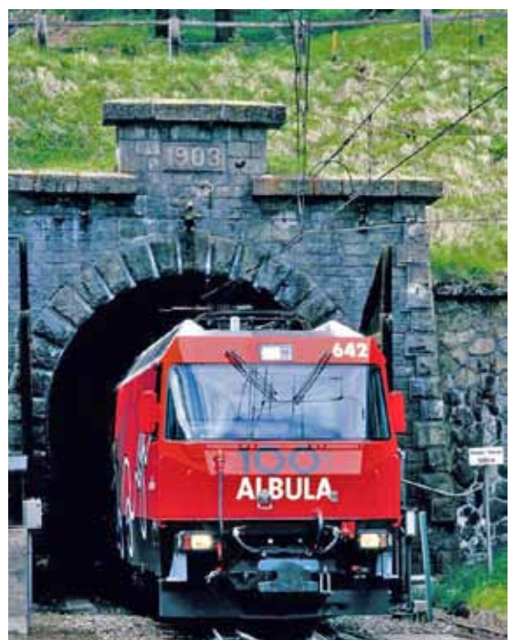
Tunnelportal im Mai 2010 (Foto: RhB)
