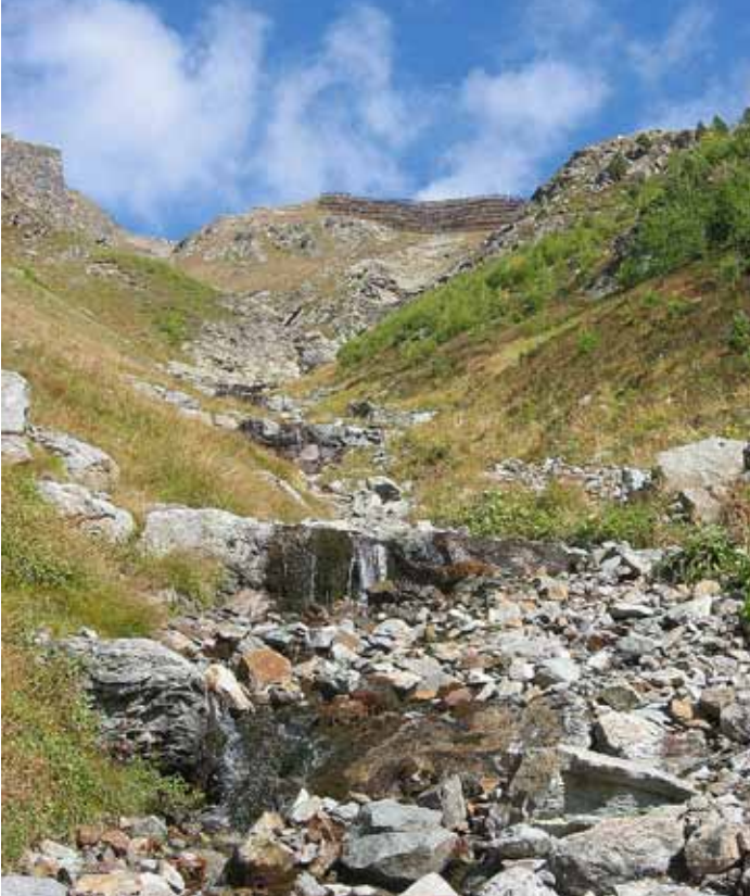
Lawinenverbauung und Murgangschutz im Val Giandains Foto: HP. Jud, 2010
