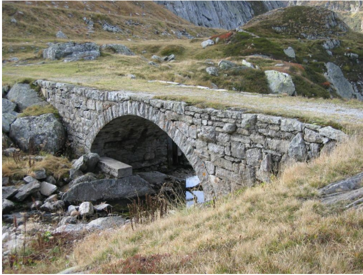
Abb. 31: Bogenbrücke „Ponte di Cima“
