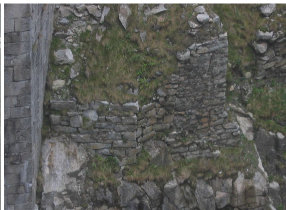
Abb. 11: Unter der Teufelsbrücke sind die Reste der Brücke zu sehen, die 1595 erbaut wurde.
