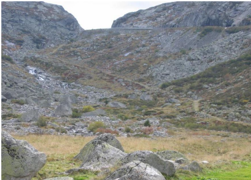
Abb. 23: Das Gotthardreusstal unterhalb von Brüggloch. Unterhalb der Kunststrasse ist der zum Teil renovierte Saumpfad sichtbar.
