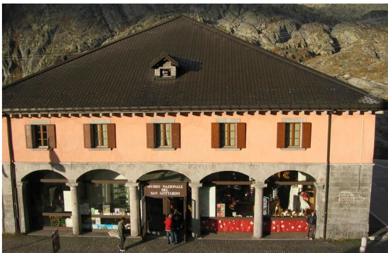
Abb. 28: Das ehemalige Zollgebäude wurde 1838 vom Kanton Tessin gebaut. Seit 1986 ist darin das Nationale Gotthard Museum untergebracht.
